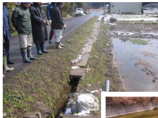
開水路の点検状況
