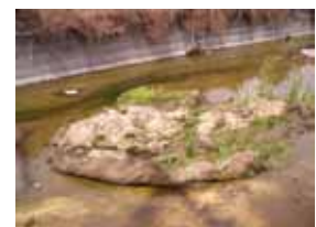
土砂の堆積状況
