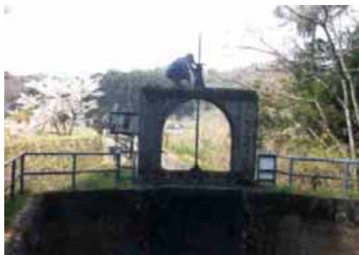
計画に基づき配水操作を実施
