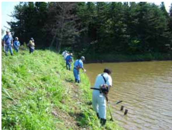
ため池堤体の草刈り
