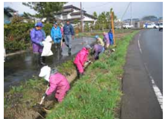
側溝の泥上げ
