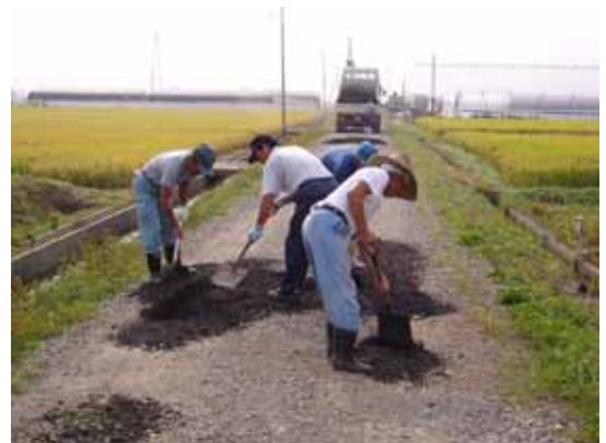
共同作業による砂利の敷き均し
