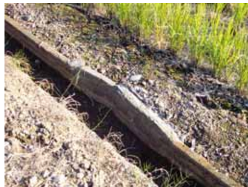
改修したU字溝
