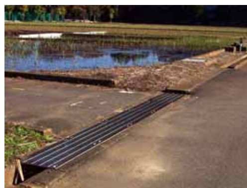
コンクリート蓋とグレーチング
