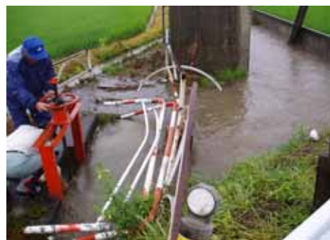
ゲートへのごみや流木の流入状況
