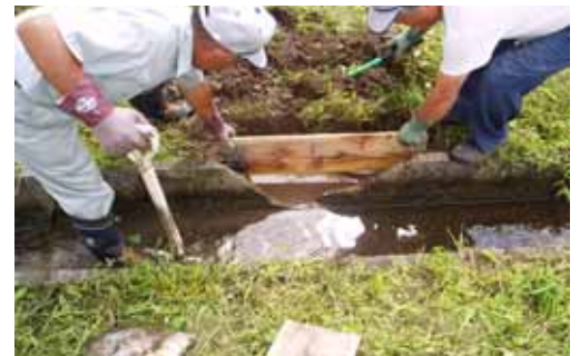
U字溝の改修作業
