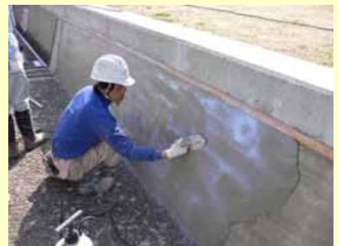
コーティング作業の状況
