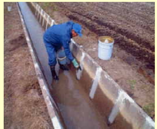
目地詰め作業
