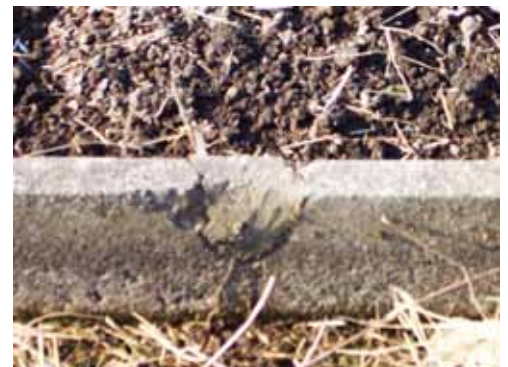
欠けた箇所の補修（側溝） （モルタルによる補修）
