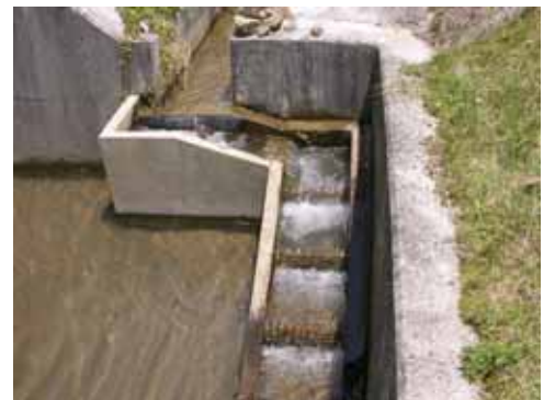
段差解消水路
