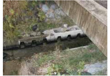
多孔コンクリート護岸
