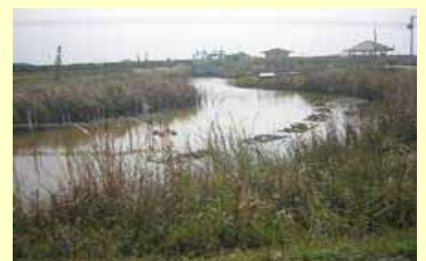
浄化池の状況
