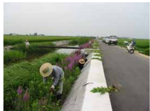
水質浄化水路
