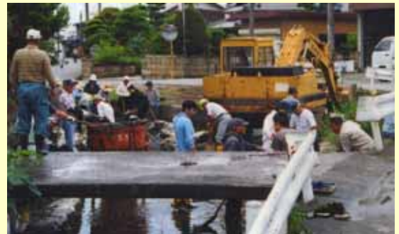
集落での泥上げ作業
