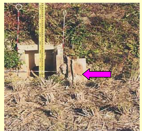
排水調整板設置状況
