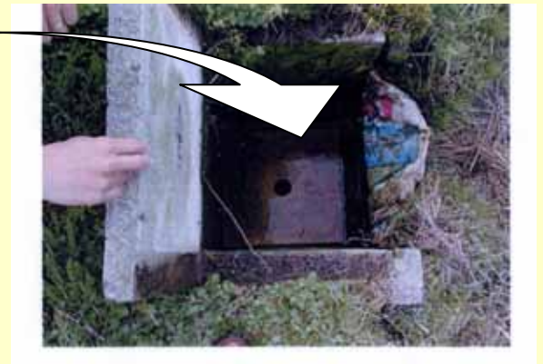
排水調整板設置状況
