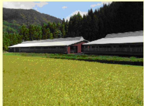
たい肥プラントの外観
