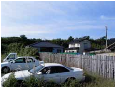
防砂垣としての活用事例
