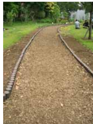
舗装材としての活用事例
