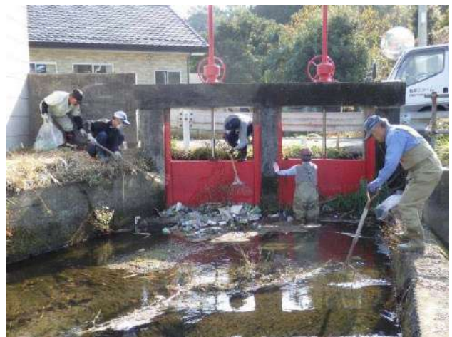
水門周辺清掃・点検
