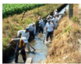
水路の泥上げ
