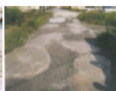
農道の窪みの補修
