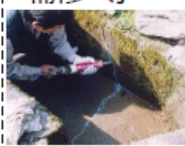
水路のひび割れ補修
