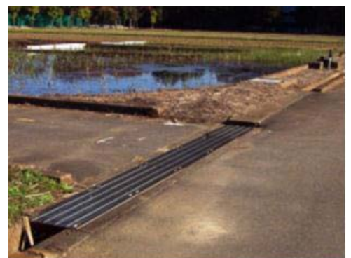
コンクリート蓋とグレーチング
