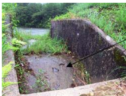
洪水吐底板（コンクリート）の欠損
