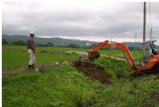
農用地法面の補修
