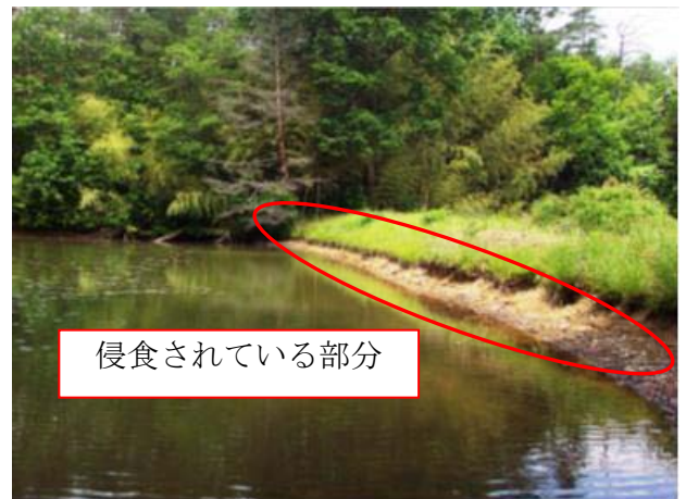
侵食が生じているため池堤体
