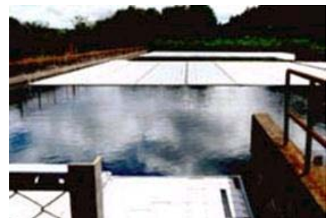
浮揚型の天蓋による部分遮光
