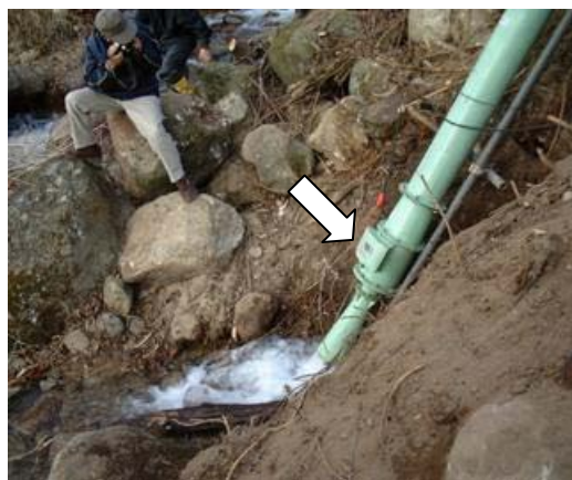
簡易な発電機 (図の矢印)
