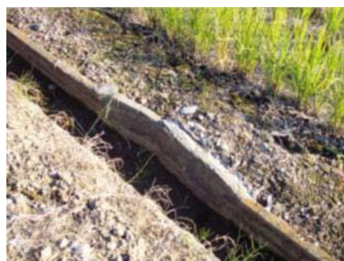
改修したU字溝
