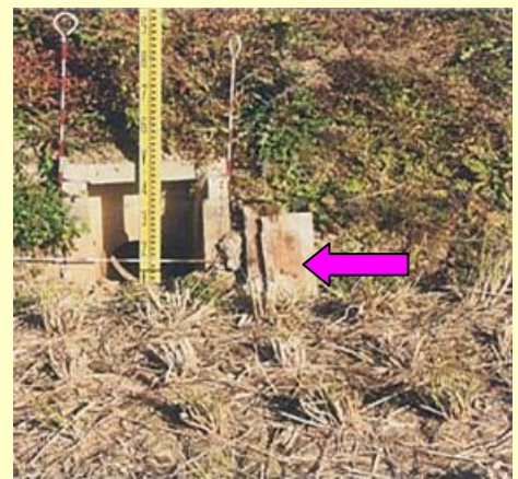
排水調整板設置状況
