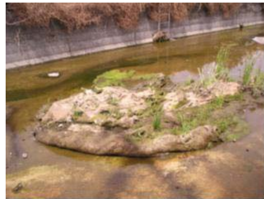
土砂の堆積状況
