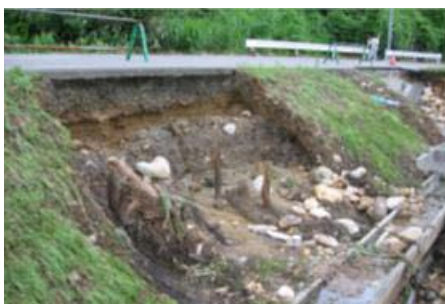
道路法面の崩壊状況
