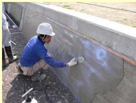
コーティング作業の状況
