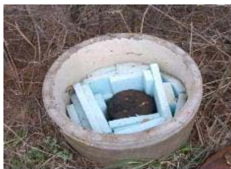
給水栓ボックス内の保温状況
