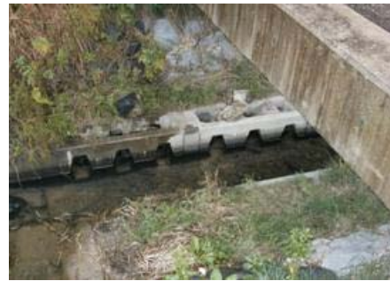
多孔コンクリート護岸
