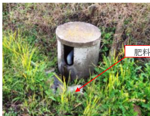
水流を緩和する クッション（肥料袋）の設置
