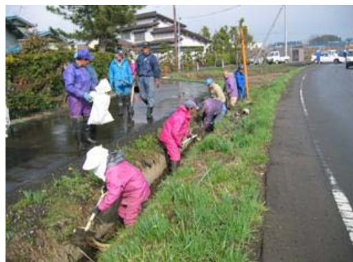
側溝の泥上げ
