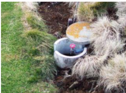
流出口の高さをほ場面に合わせた 給水栓ボックス
