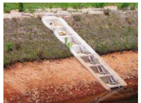
斜樋と取水栓（コンクリート製品）
