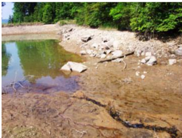
ため池に流入した土砂
