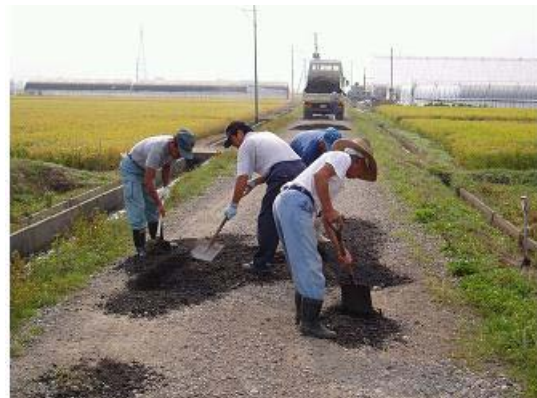
共同作業による砂利の敷き均し
