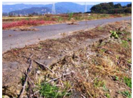
路肩の浸食と路面下の空洞
