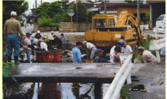
集落での泥上げ作業
