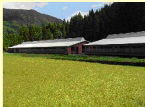
たい肥プラントの外観
