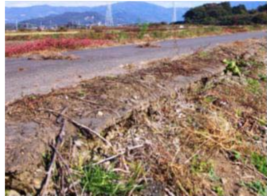
路肩の浸食と路面下の空洞
