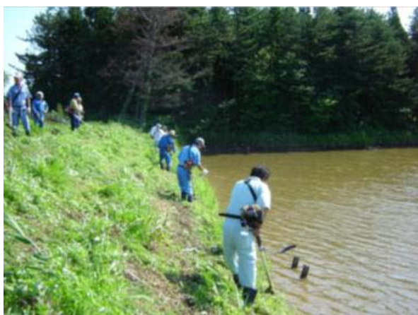
ため池堤体の草刈り
