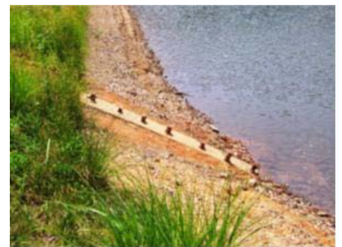
斜樋と取水栓
