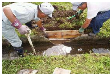
U字溝の改修作業
