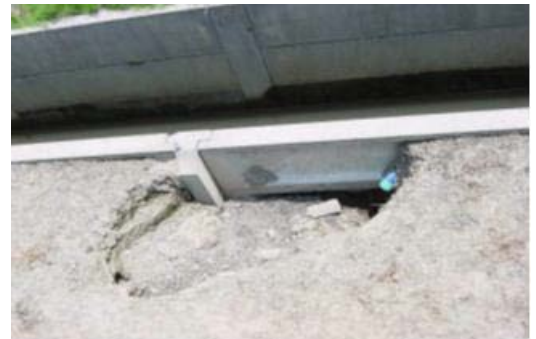
水路側壁の空洞状況
