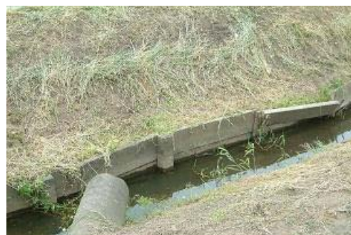
水路側壁のはらみの状況
