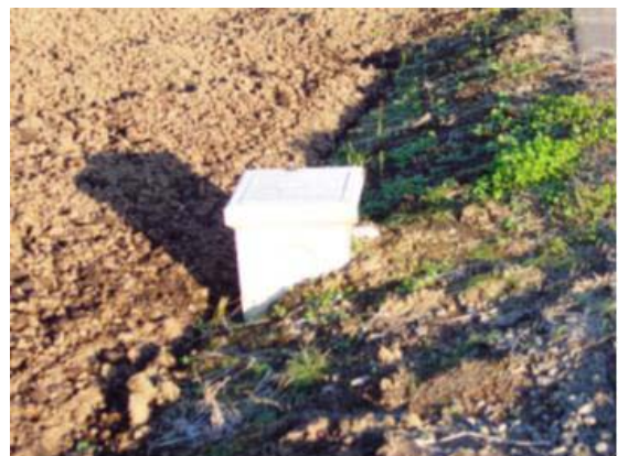
傾いた給水栓ボックス
