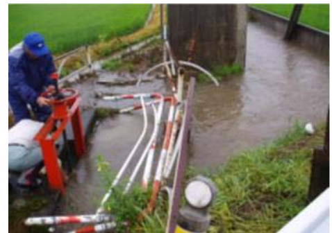
ゲートへのごみや流木の流入状況
