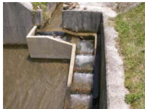
段差解消水路
