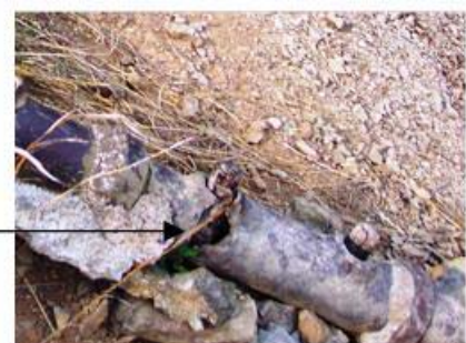
古い樋管（陶製）の破損
