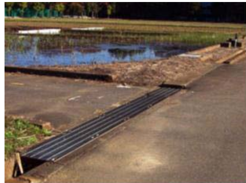
コンクリート蓋とグレーチング
