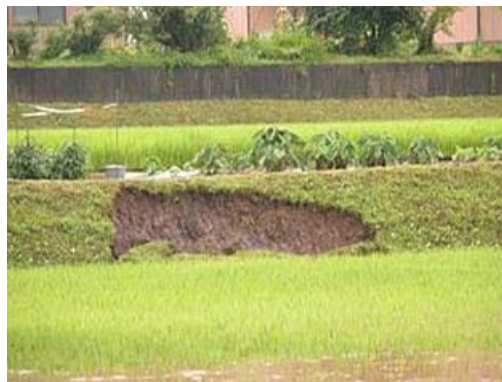
法面の崩壊状況
