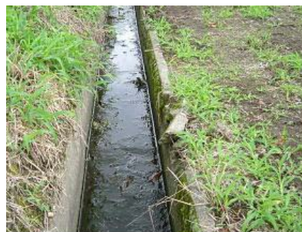
破損したU字溝
