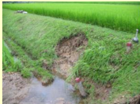
農用地法面が崩れた状況
