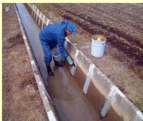
目地詰め作業
