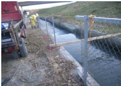
金網フェンスの 設置
