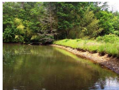
堤体が洗掘されているため池
