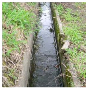
部分的な欠損
