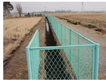
新たに設置された 金網フェンス
