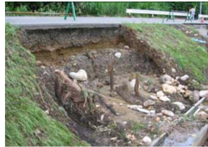
道路法面の崩壊
