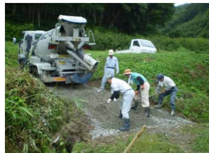
コンクリート舗装状況
