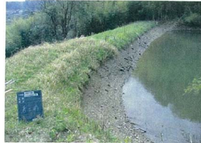
漏水が生じているため池
