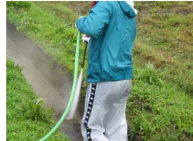
高圧洗浄機による 水路内の清掃
