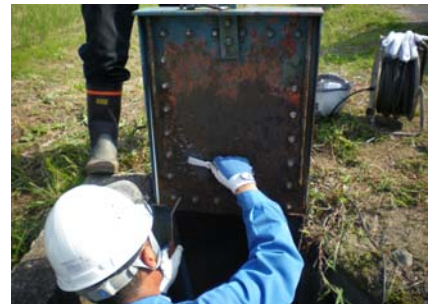
ゲートの補修状況
