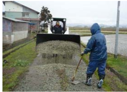
砂利の敷き均し
