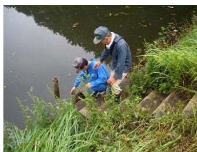
取水施設の点検
