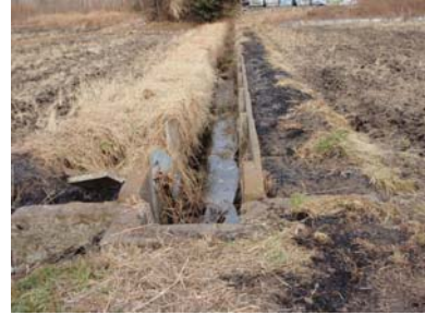
老朽化した水路（全景）
