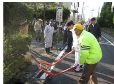
水路蓋の設置 (専用器具使用)
