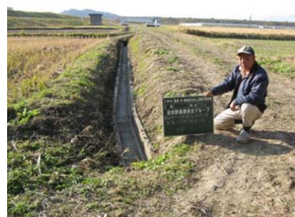
土側溝をコンクリート側溝に更新
