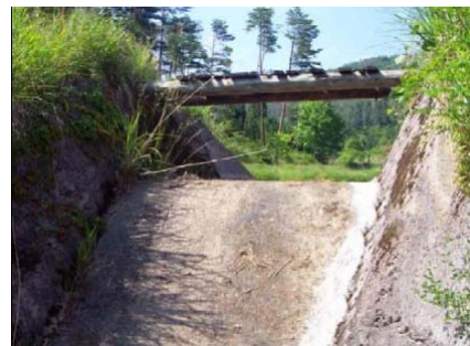
洪水吐の補修
