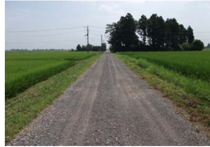
未舗装農道（砂利の路面）
