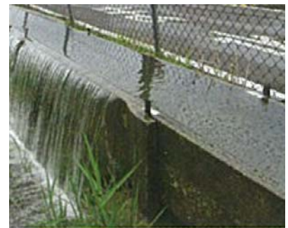
水路からの溢水
