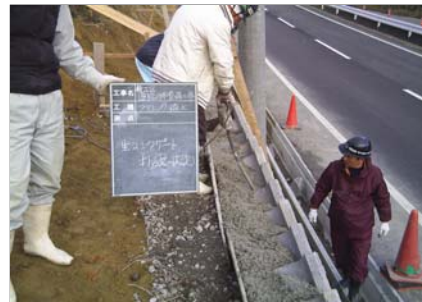
ブロック積みの施工
