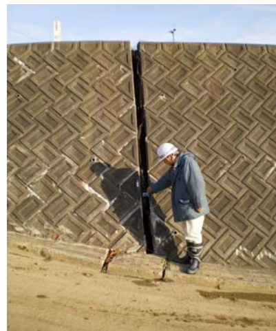
ブロック積みの隙間
