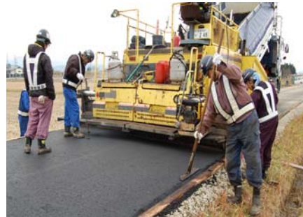
アスファルト舗装状況
