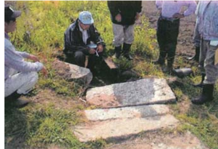
側溝蓋の損傷
