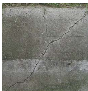
斜め方向のひび割れ
