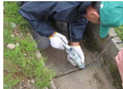
シーリング材充填
