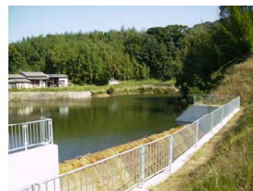
金網フェンスの設置状況
