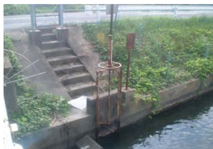
老朽化したゲート
