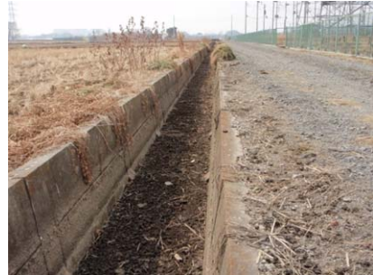
安全施設がない水路
