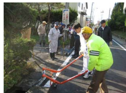
水路蓋の設置 (専用器具使用)
