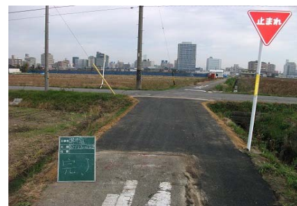
アスファルト舗装の打換え
