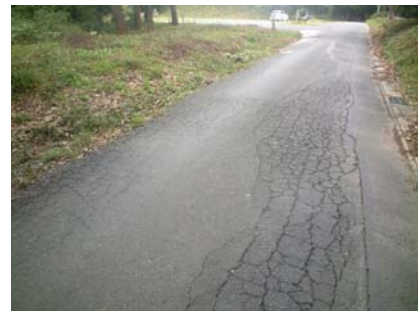
アスファルト舗装の老朽化
