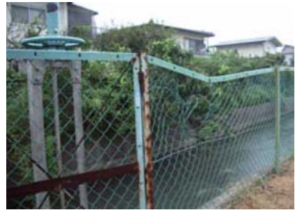
破損した金網フェンス
