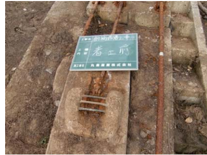
ため池における 老朽化したゲート
