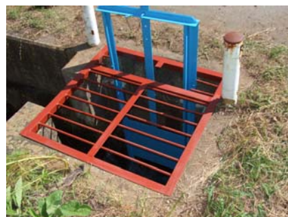
更新後のゲート
