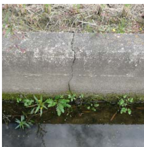
縦方向のひび割れ
