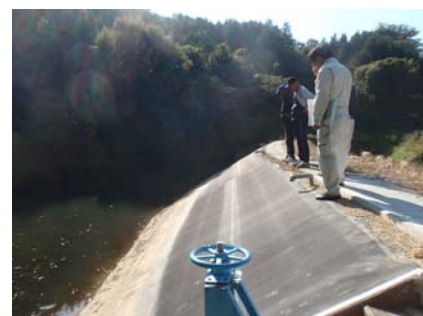
遮水シートの設置
