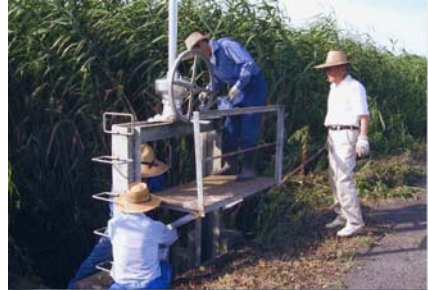
ゲートの点検
