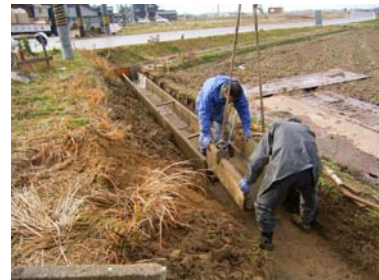
水路の再布設
