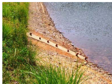
老朽化した取水施設
