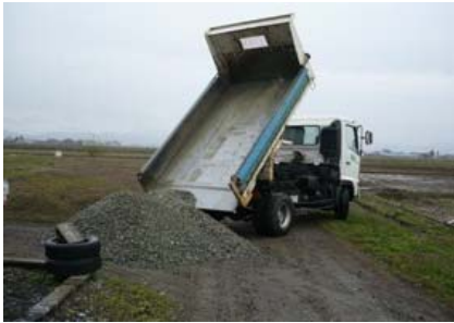
砂利の荷下ろし
