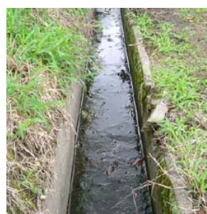
部分的な欠損
