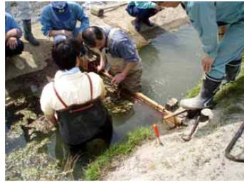
魚道の設置状況（堰板の設置）
