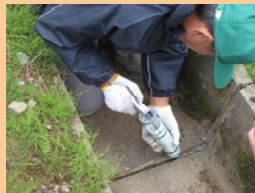
■ 水路の老朽化箇所の補修
