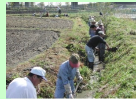
■ 水路の保全管理
