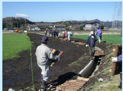
水路に木製蓋を設置
