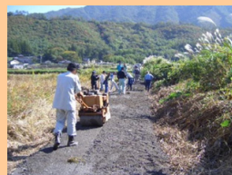
■ 農道舗装の補修
