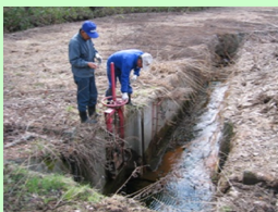
■ 点検・機能診断
