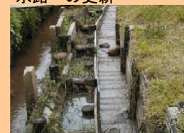
■ 水田魚道の設置
