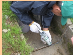
■ 水路の老朽化箇所の補修
