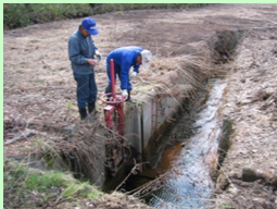
■ 点検・機能診断
