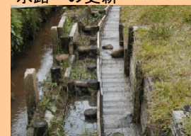
■ 水田魚道の設置
