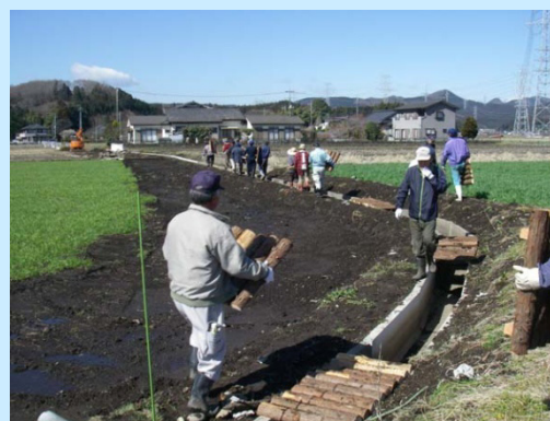
水路に木製蓋を設置
