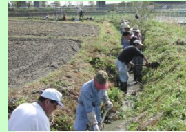
■ 水路の保全管理
