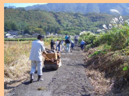
■ 農道舗装の補修
