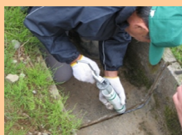
■ 水路の老朽化箇所の補修
