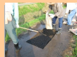
■ 農道舗装の補修
