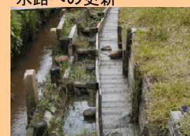
■ 水田魚道の設置
