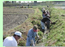
■ 水路の保全管理
