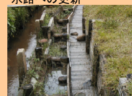
■ 水田魚道の設置
