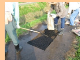
■ 農道舗装の補修
