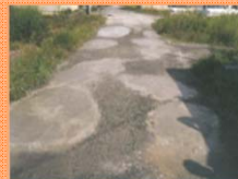
農道の窪みの補修
