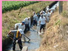
水路の泥上げ
