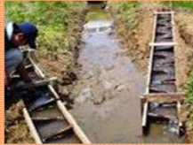
水田魚道の設置
