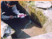
水路のひび割れ補修
