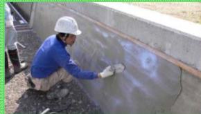
老朽化した水路壁のコーティング
