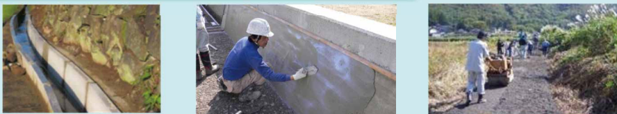
素掘り水路からコンクリート水路への更新 老朽化した水路壁のコーティング 未舗装の農道をアスファルトで舗装
