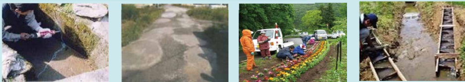
水路のひび割れ補修 農道の窪みの補修 植栽活動 水田魚道の設置
