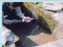
水路のひび割れ補修
