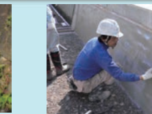
老朽化した水路壁のコーティング
