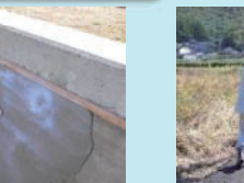
老朽化した水路壁のコーティング
