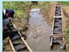
水田魚道の設置
