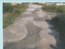
農道の窪みの補修
