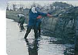
●水路の泥上げ
