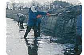
●水路の土砂上げ
