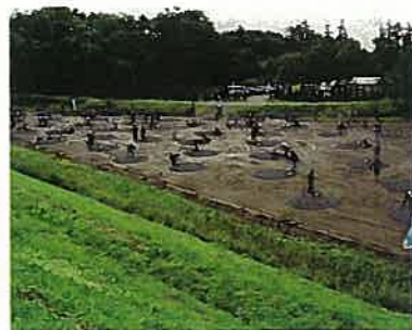
えん堤周辺の植樹(長沼町)
