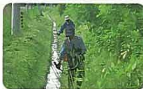
●用水路の草刈り
