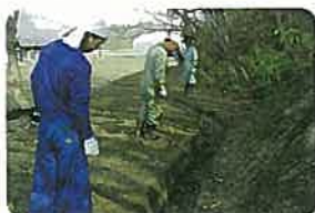
●施設(用水路)の点検
