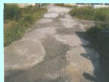
農道の窪みの補修
