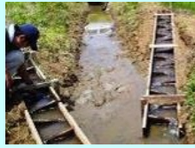
水田魚道の設置
