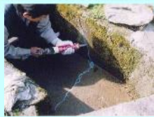
水路のひび割れ補修
