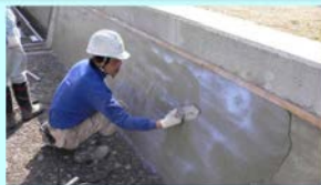
老朽化した水路壁のコーティング
