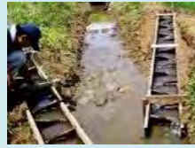
水田魚道の設置
