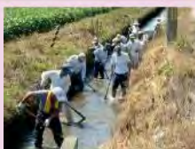
水路の泥上げ
