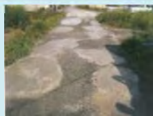
農道の窪みの補修
