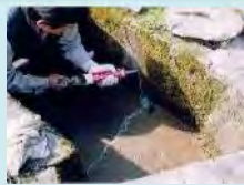
水路のひび割れ補修
