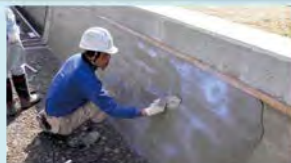
老朽化した水路壁のコーティング
