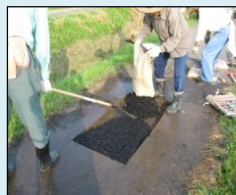
農道の部分補修
