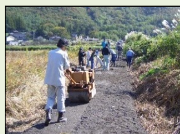
未舗装農道の舗装
