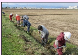
水路の泥上げ
