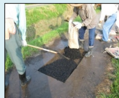
農道の部分補修
