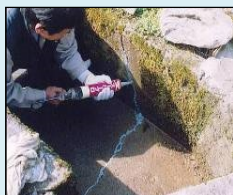
ひび割れの補修
