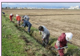
水路の泥上げ
