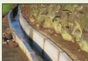
素堀り水路からの更新
