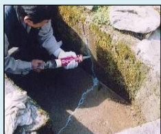
ひび割れの補修
