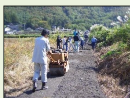
未舗装農道の舗装
